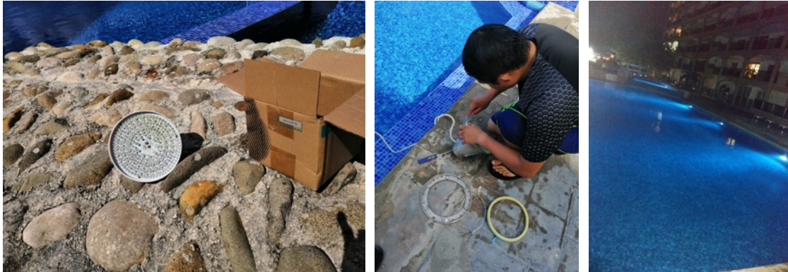
Reparación de Huevo:
