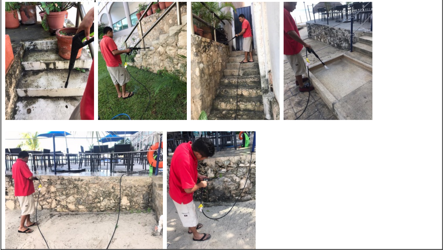
Reparación y Limpieza:
