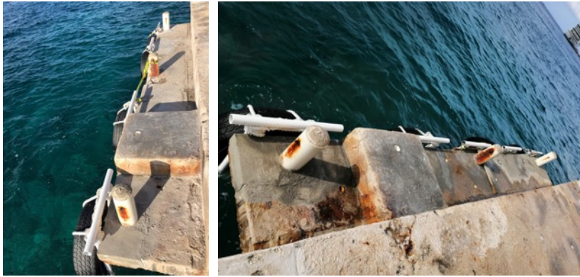
-Se reparó el área del muelle por la escalera-
