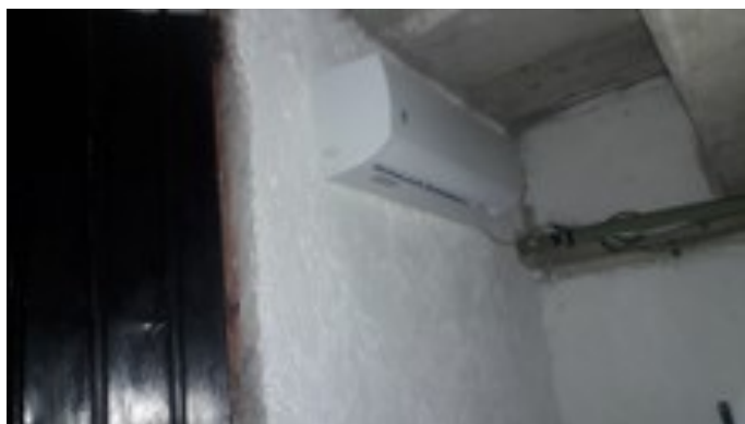
Se instalaron líneas de drenaje en el cemento:
