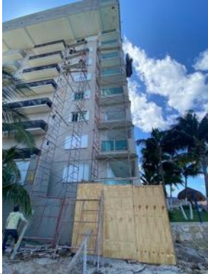
PHC-S Durarock Repair / Reparamos Durarock
