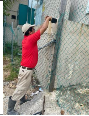
Mantenimiento a la Reja:
