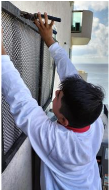
Se Reparó la Entrada de Granito del Elevador:
