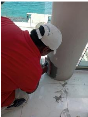
Reparación de Oxido en Columna y de Cemento:
