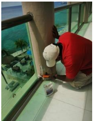
Reparación de Oxido en Columna y de Cemento:
