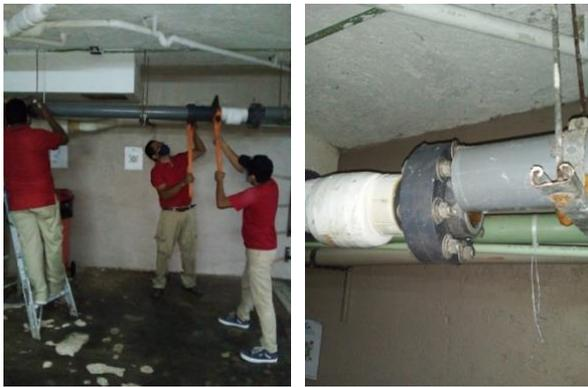
Se Reemplazó una Válvula Check que no Funcionaba:
