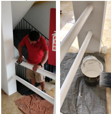
-Retoque de Pintura en los Barandales/Escaleras-
