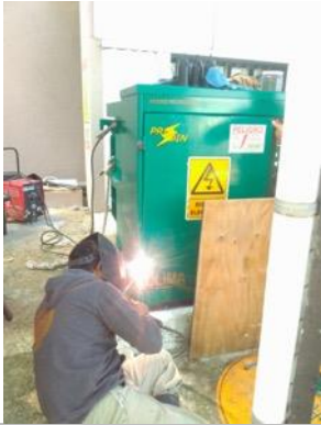
- Se dio Mantenimiento al Transformador (Óxido) –
