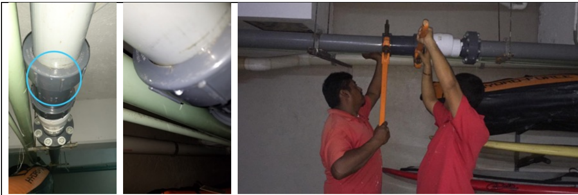
-Varias Reparaciones en Suavizadores de Agua-
