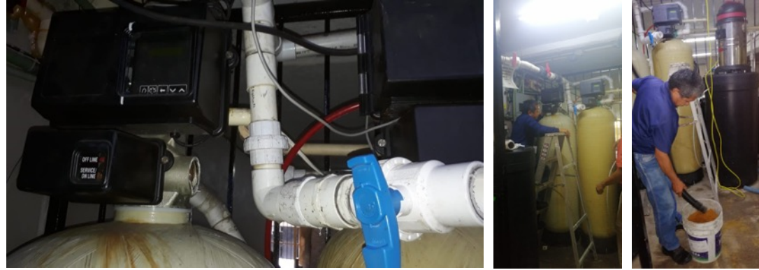
-Reparamos con Fibra de Vidrio un tanque-
