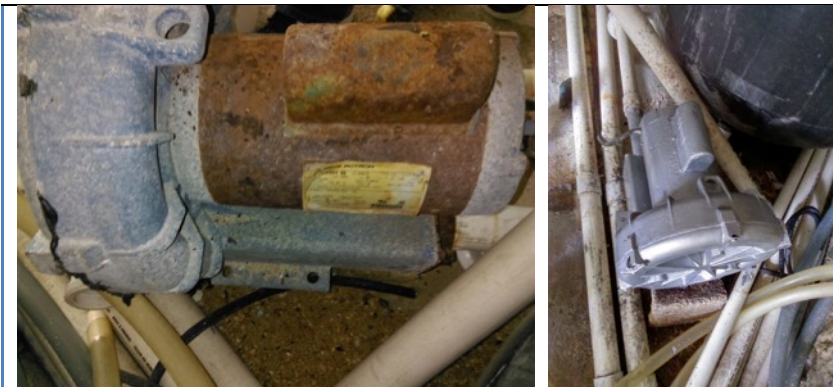
Las rejillas que estaban rotas, oxidadas y que eran un peligro para las personas se reemplazaron:
