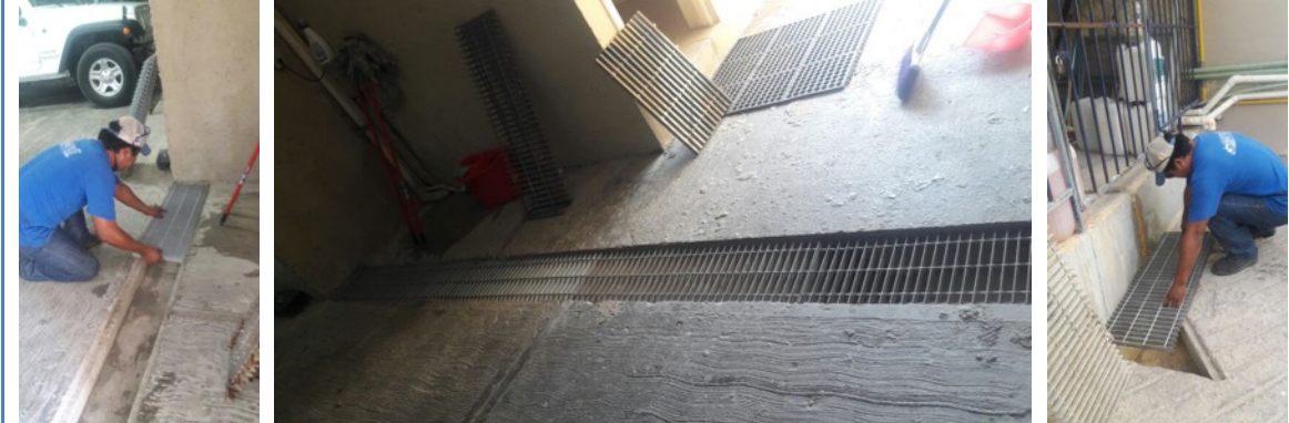
Se extendió el ducto de ventilación para el calentador de la alberca unos pies más:
